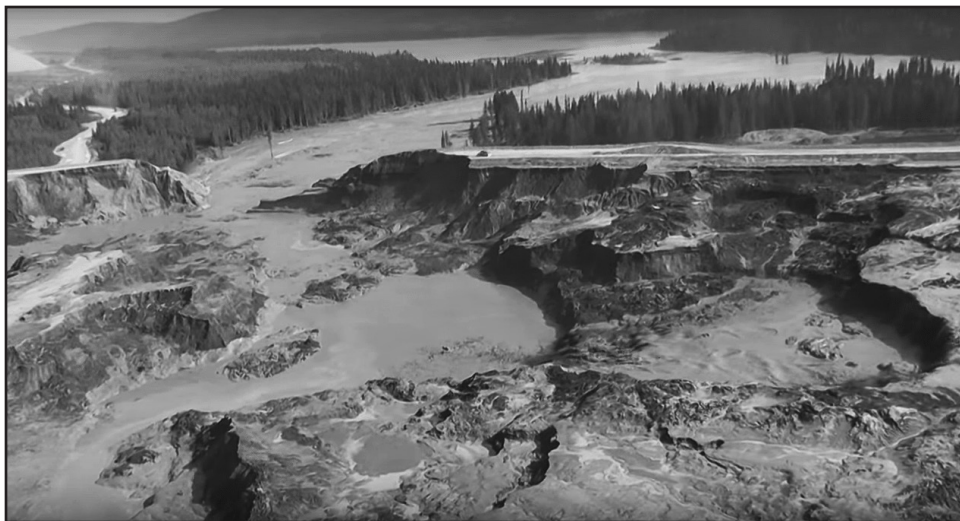
Rompimento da barragem de rejeitos da mina de Mount Polley, agosto de 2014. Foto: Distrito Regional de Cariboo (cortesia).
